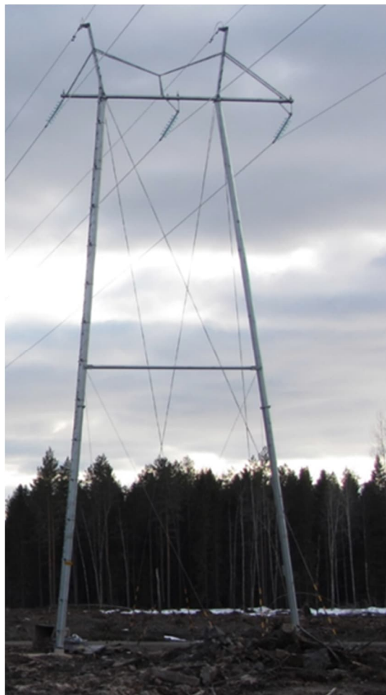
Kuva 2. Vapaasti seisova 110 kV voimajohtopylväs ja harustettu 110 kV voimajohtopylväs, (TLT-B. 2022).
