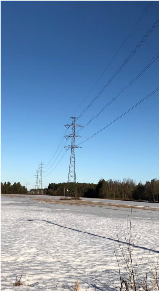
Kuva 2. Vapaasti seisova 110 kV voimajohtopylväs ja harustettu 110 kV voimajohtopylväs, (TLT-B. 2022).
